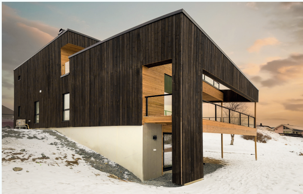
Boliger med sokkel kan ha ekstra fukttekniske utfordringer siden kjellerveggen ligger delvis over og under terreng. Bad, vaskerom, korridorer og tekniske rom er ofte plassert i bakre del, mens det er vanlig at soverom og oppholdsrom har én eller flere vegger mot terreng og minst én vegg med vinduer. Foto: Norgeshus.
