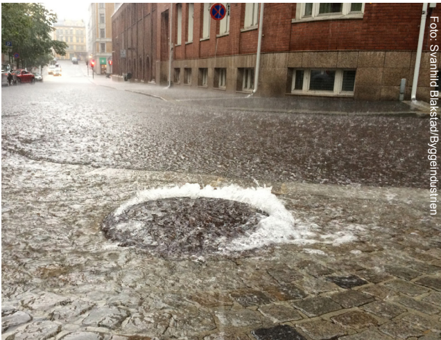
Lokal, kortvarig og intens nedbør har sprengt avløpskapasiteten.
