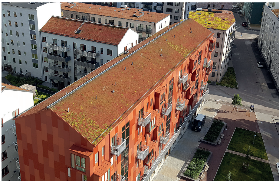
Figur 1: Gröna tak är vanliga i den nybyggda stadsdelen Kvillebäcken i Göteborg för att omhänderta dagvatten. Bilden är tagen i slutet på juli efter en längre torr period varför taken är röda.
