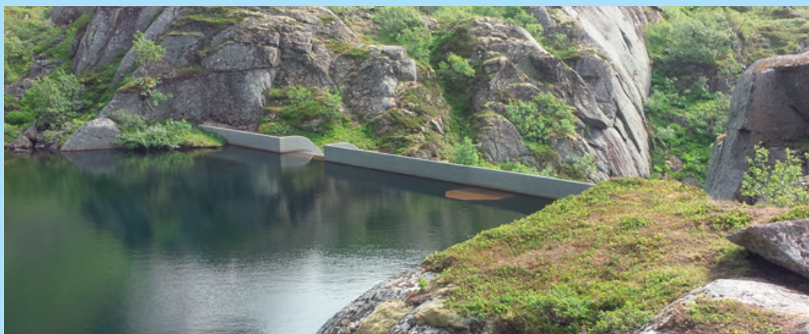
Brettesnes vannverk henter råvannet fra en oppdemmet innsjø på 315 m.o.h.
