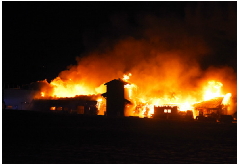
18. desember 2018 brant avløpsrensaneanlegget ned til grunnen. Foto: Østre Toten kommune
