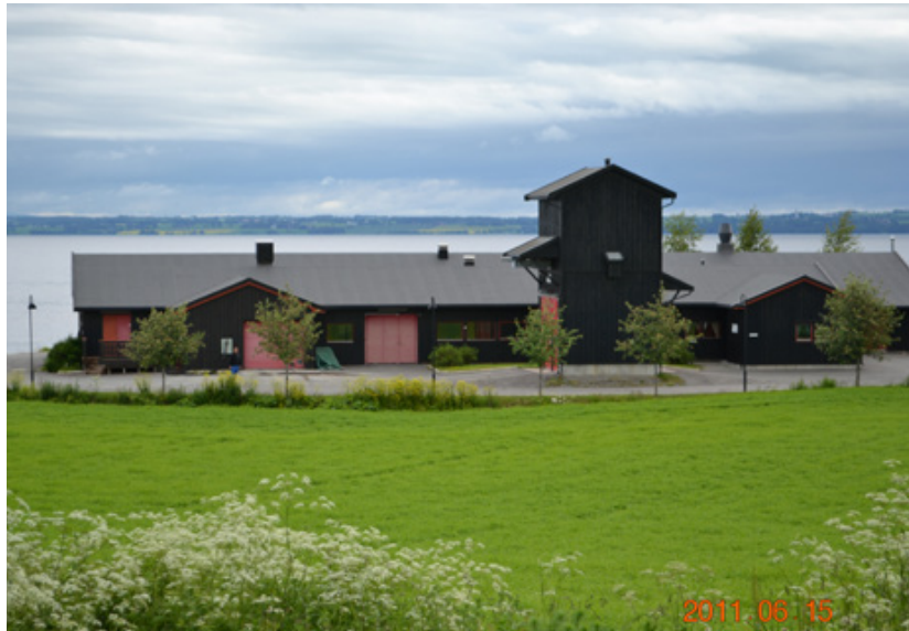
Skreia avløpsrensaneanlegg i Østre Toten kommune, slik det så ut før brannen. Foto: Østre Toten kommune
