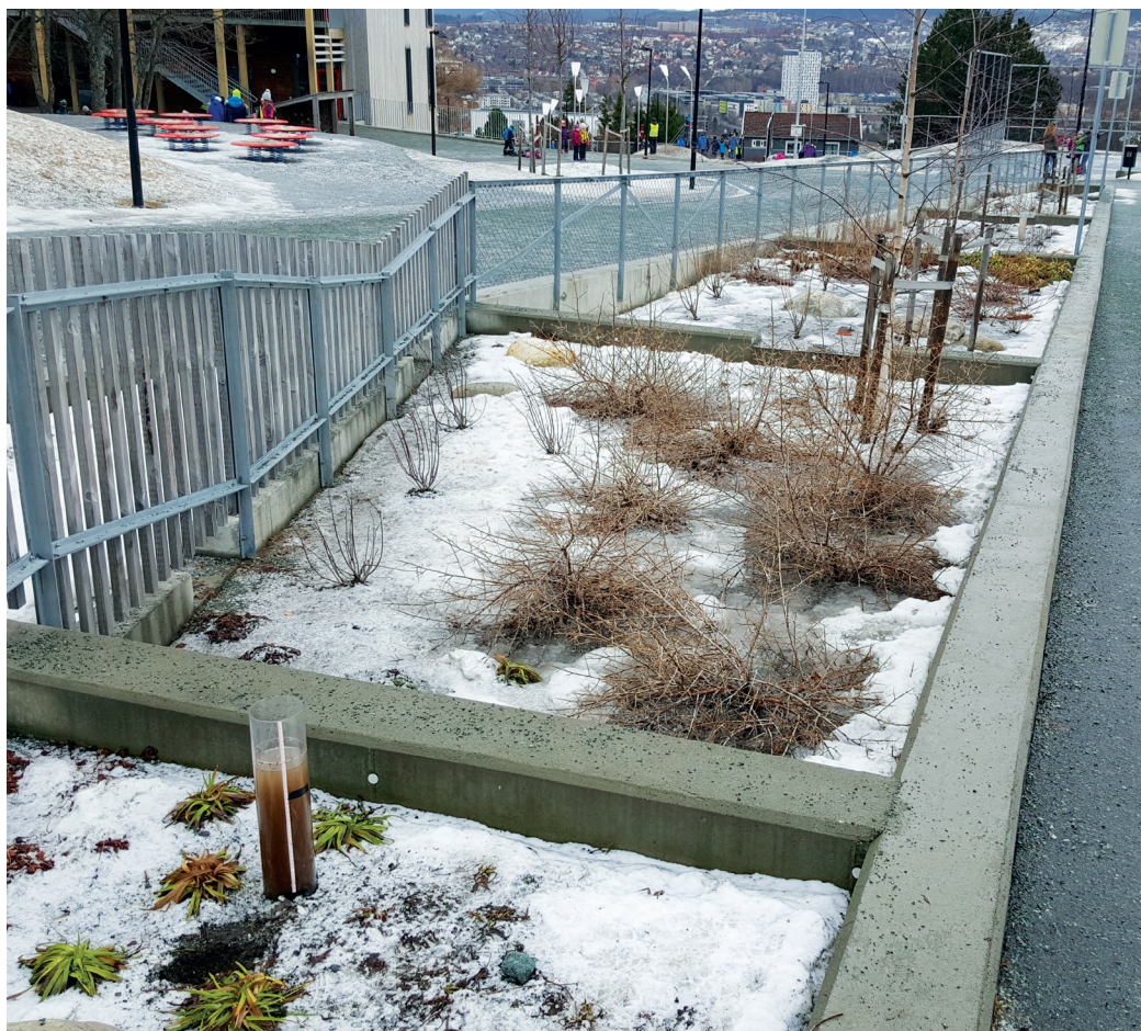
Måling av infiltrasjonsevne til regnbed ved Åsveien skole i Trondheim.
