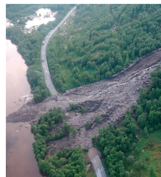
FLOMSKRED I HUNNEDELEN, JUNI 2016. Utvikling av effektive sikrings tiltak mot slike skred krever bedre skredforståelse enn vi har i dag.
