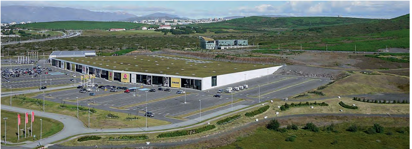
Grønne tak på kjøpesenter samt gresskledd vannveier (swales) på parkeringsplasser og i området rundt bidrar til overvannshåndteringen. Foto Arni Geirsson, Alta hf.
