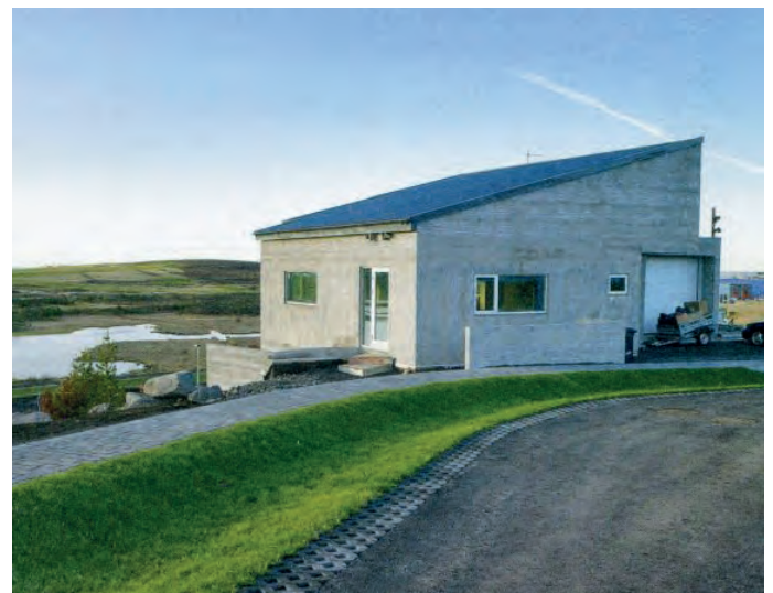
Gate med gresskledd vannveg (swale) mellom permeable dekker på gangveg og kjørearealer
