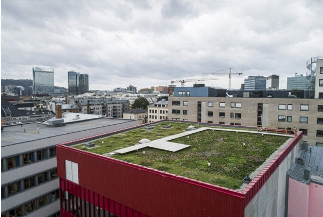
Figur 7: Blågrønt tak på Vega Scene i Hausmannsgate 28 i Oslo. Dronefoto: Asplan Viak.
