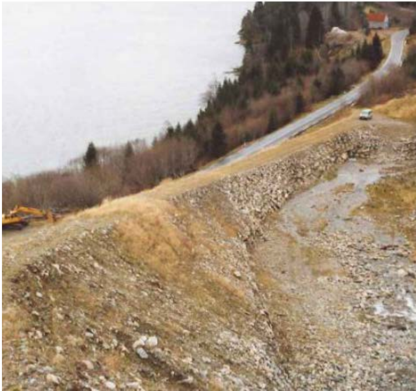
Deflection wall in Sandvika, Sogn og Fjordane (Photo: Harald Norem)
