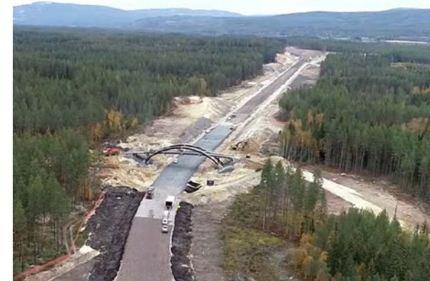
Foto; Skanska, fr RV3/Rv25 Ommangsvollen – Grundset/Basthjørnet ved Elverum
