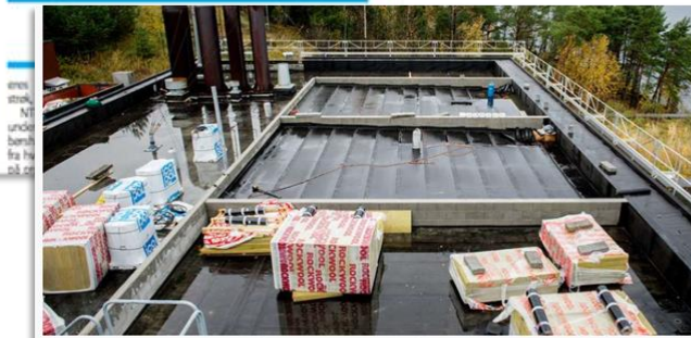
På dette taket på Høvringen renseanlegg skal forskingssenteret Klima 2050 våren 2016 etablere en feltstasjon som skal finne løsningene oversvømmelser utløst av ekstremregn. FOTO: OLE MARTIN WOLD
