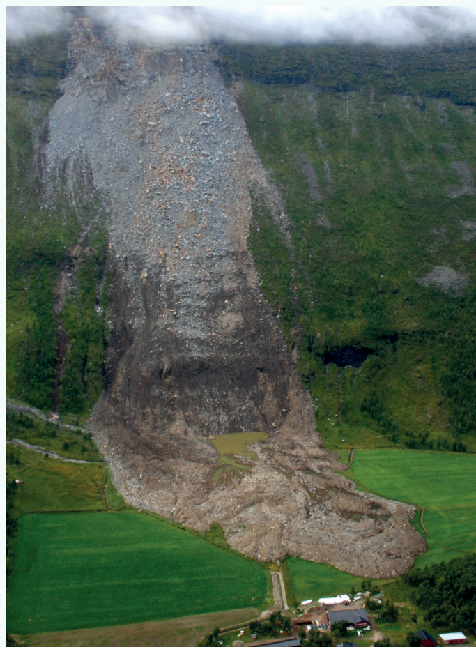
Jordskred fra Heimgårdsberget, Signaldalen, Troms fylke. Foto: Iain Henderson, NGU
