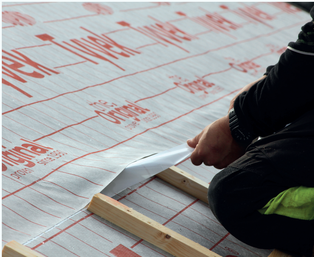
Klebefelt i skjøt i kombinert undertak og vindsperre. Her fjernes den beskyttende strimmelen under legging av taket før sammenliming. Foto: Isola
