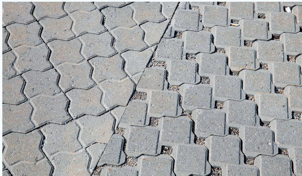
Vanlig belegningsstein (venstre) og belegningsstein beregnet for permeabelt dekke (høyre). Foto: ASAK Miljøstein
