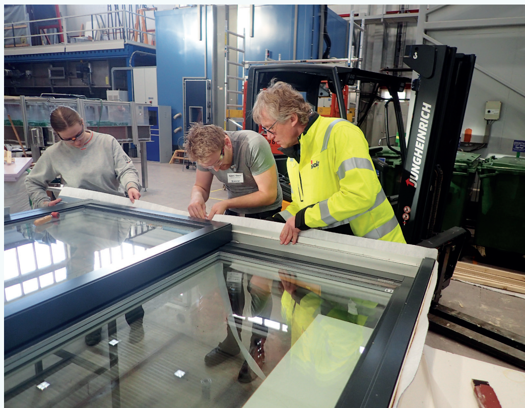
Jørgen Young (Isola) rettleder Rudi Bjørkeland fra NorDan og masterstudent Torill Raugstad i riktig teipeteknikk for Isola Flextett Vindusrim. Vindusrim'en muliggjør luft- og regntett innsetting av terrasseskyvedøren uten bruk av fugemasse og tetteliste.
