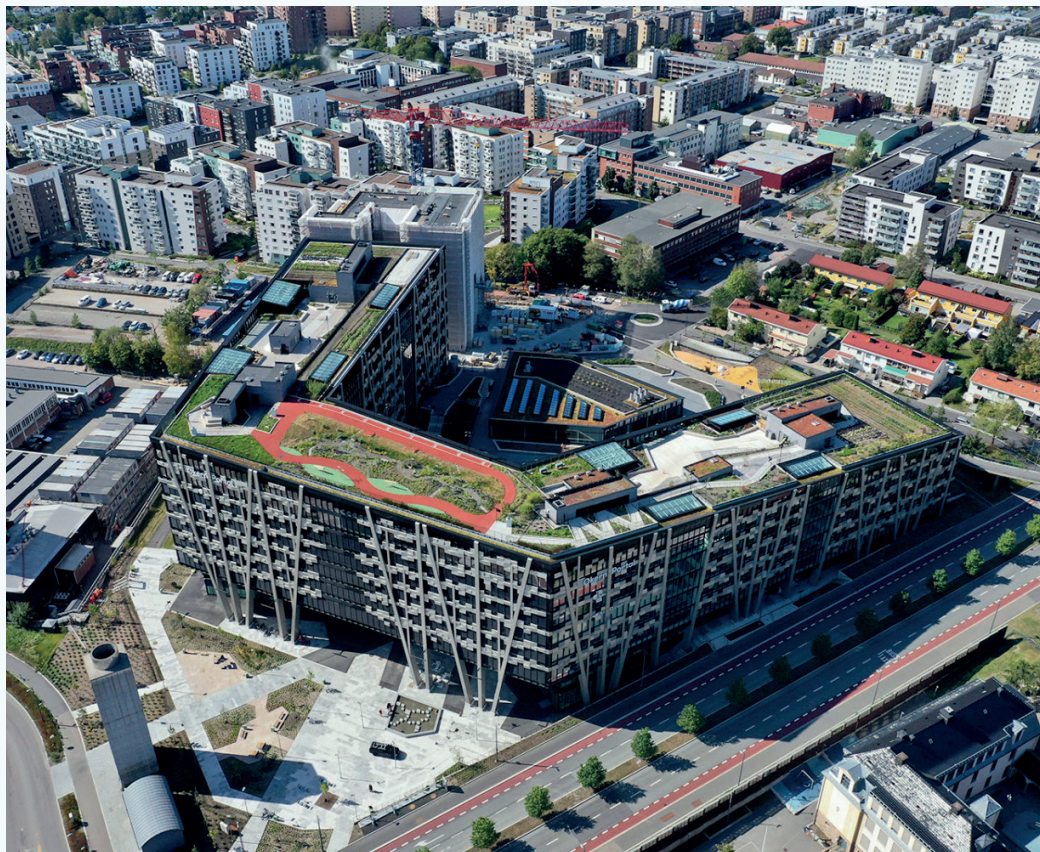
Taket på Økern Portal er et godt eksempel på hvordan takarealet kan erstatte areal på bakkenivå.
