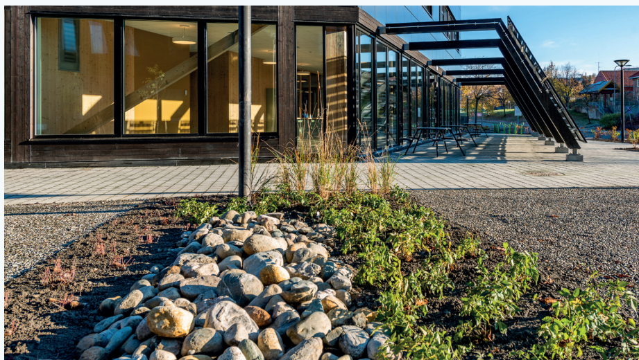
ZEB-laboratoriet på Gløshaugen i Trondheim er en viktig forskningsinfrastruktur også for utvikling av nye overvannsløsninger. Foto: m.c.herzog / visualis-images
