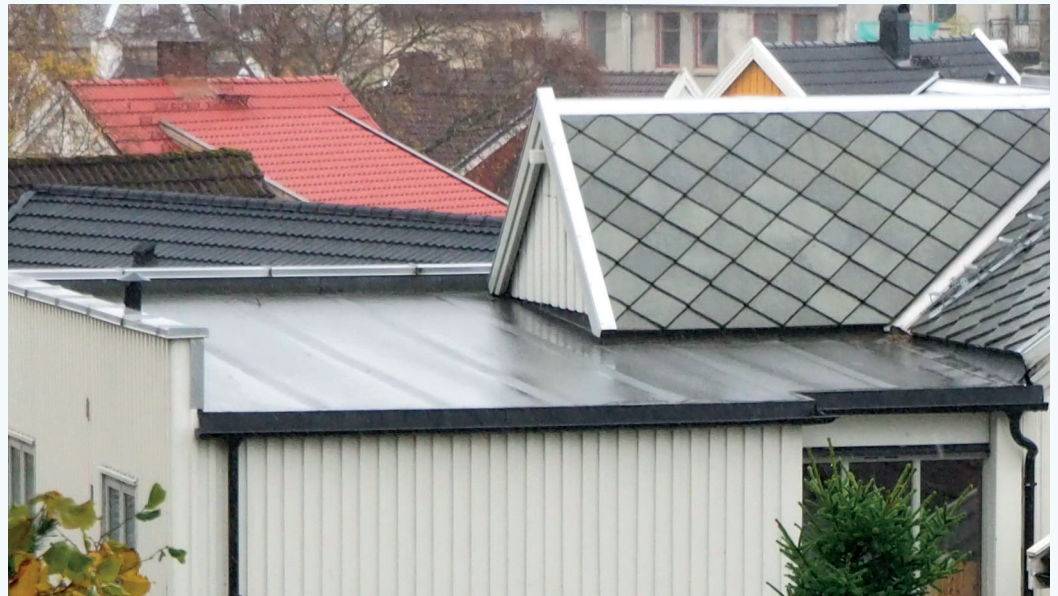
Eksempel på kompakt tak med utvendig nedløp.
