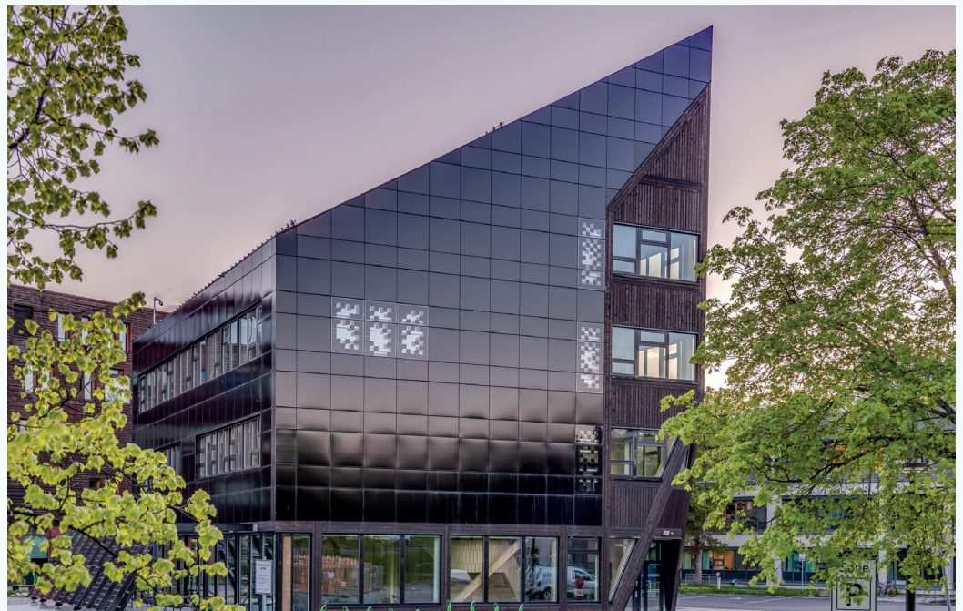
ZEB-laboratoriet på Gløshaugen i Trondheim har bygningsintegreerte solceller på alle flater med stor nok soltilgang. Her er utvikla nye løysningar, og erfaringar frå prosjektet er no samla i rapport SINTEF Fag 82.
