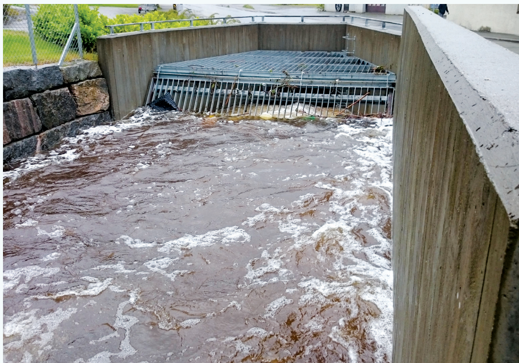
Flom i små nedbørsfelt er eit aukande problem. Nye hydrologiske analyseverkty gir no betre underlag for dimensjonering av for eksempel kulvertar. Foto: Knut Alfredsen.
