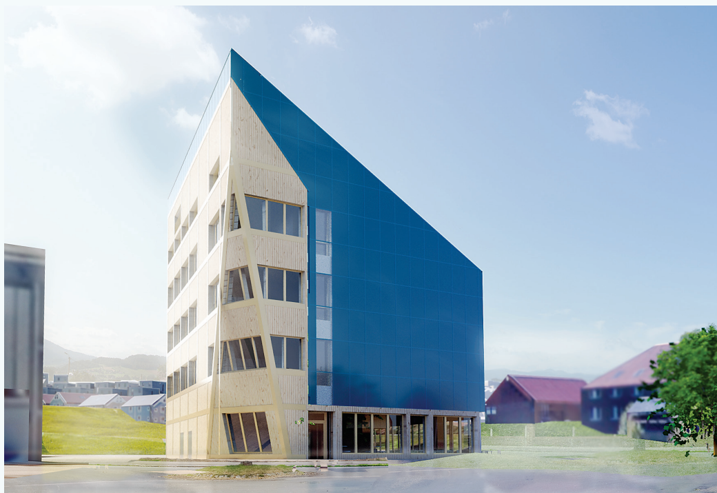
ZEB-laboratoriet har hele takflaten vendt mot sør for optimal strømproduksjon med solceller.
