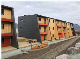
Dei siste nye dubbelbalkene i Slettestrâtt i Longyearbyen er eit av pilotprosjektene i Klima 2050 med smart dampsperrer i yttertak. Bildet er bygd som eksempel av Skanska. Nordbalken, K100. Foto: Erlend Bakketeig, slettestrâtt
