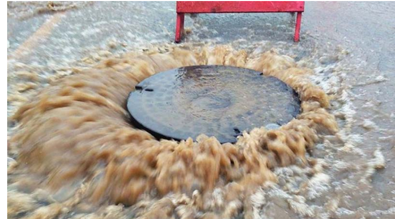
Flom på Nøtterøy i september 2015 Foto: Vestfold interkommunale brannvesen VIB
